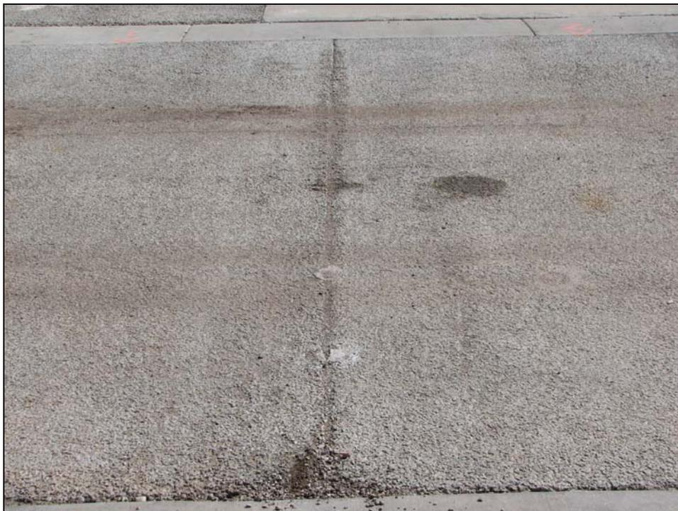
**FIGURE D-6: Tooled joint, 4.02.09.**
