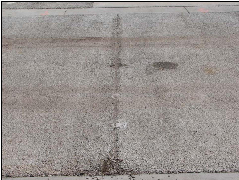
**FIGURE D-6: Tooled joint, 4.02.09.**
