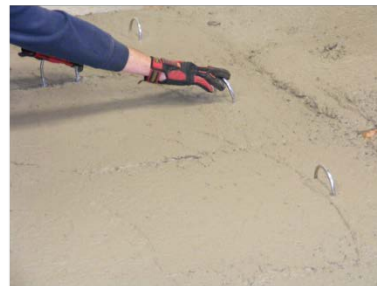
(d) Lifting hook placement
