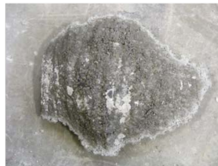
(d) Fully debonded patch
